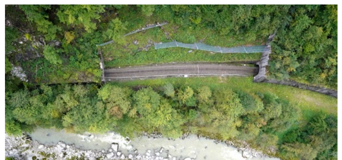
Abb. 5: Hochauflösende Bilder zur Kontrolle von Schwellen, Masten, Lärmschutzwänden und zur Vegetationskontrolle (Baumwurfradius)
